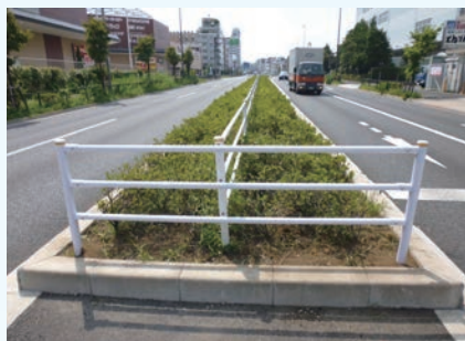
ガードパイプ
