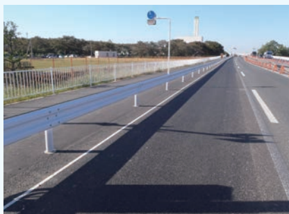
ガードレール
